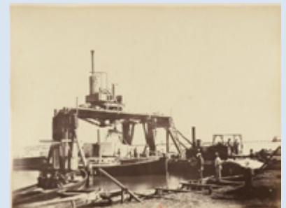
Grue servant à embarquer les blocs
